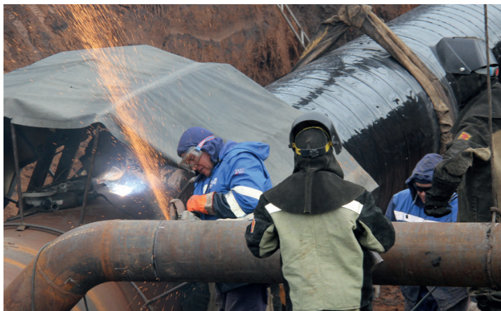
Подготовка сварного стыка слесарями
